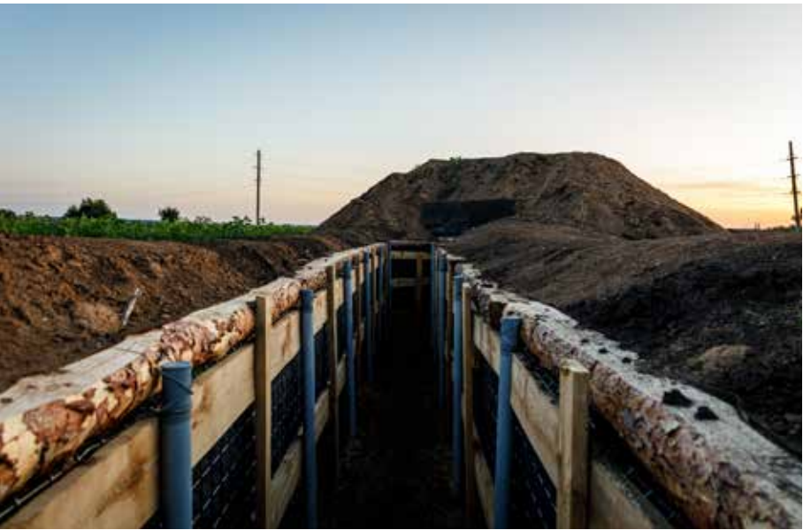
Zicht op het loopgravenstelsel aan de oostrand van Sviatohirsk in de richting van een uitkijkpost. De heuvels op de achtergrond dienen als camouflage en bescherming
